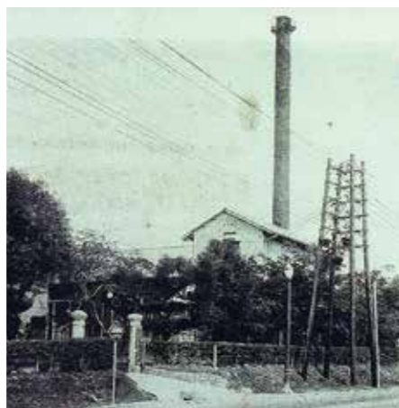
▲高雄第一火力發電所。（圖片出處／臺灣電力公司網站）
