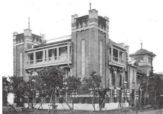
▲以鋼網混凝土技術興建的臺灣土地建物株式會社事務所。
