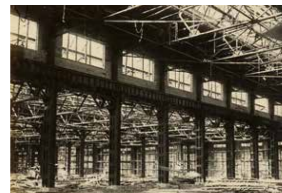
▲鋼骨鋼筋混凝土造新式廠房內部。
