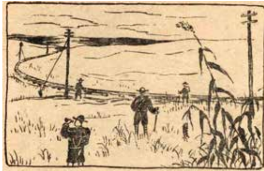
▲防護團警護班團員巡視鐵道、電信設備。（出處：《臺灣の防衛》）
