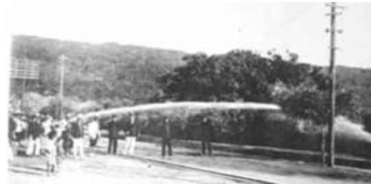
▲臺中「清水水道」開通時測試消防栓水力的情景(出處：清水街《清水水道》，1929)
