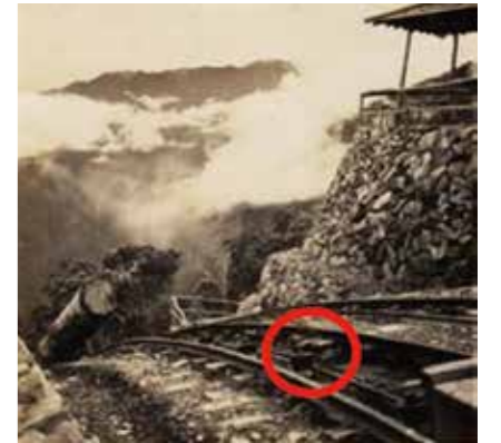
▲ 斜頭角站地面軌道之受索輪位置與安裝方式。（圖片來源／典藏臺灣網站）
