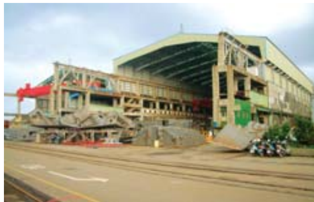
▲臺灣造船廠生產廠房。
