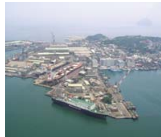
▲直升機空照臺船基隆廠全貌。
