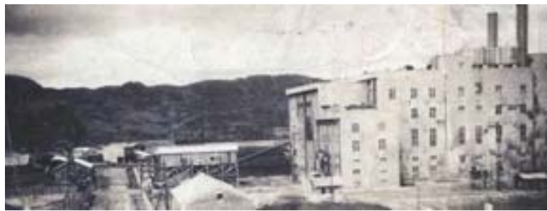
▲基隆北部火力發電所。
