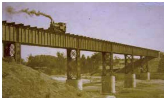
▲鋪軌道的官田溪渡槽橋。
