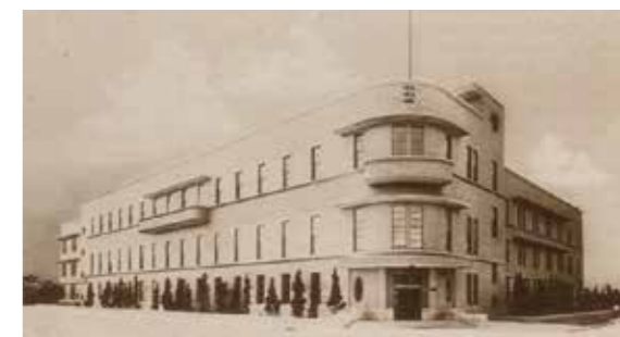
▲臺北電話交換局。（資料來源：《臺北自動電話開局特輯號》，臺灣交通產業社）
